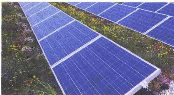
**ENERGIA DAL SOLE.** Per la produzione di energia elettrica è stato installato sul giardino pensile del tetto un impianto fotovoltaico da 10 kW in silicio policristallino.
